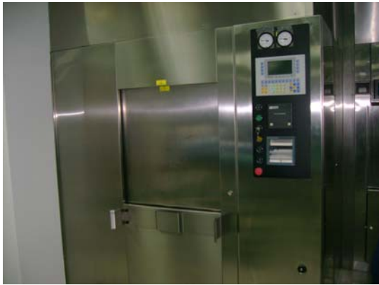
.....ΜΗΧΑΝΗΜΑ ΠΡΙΝ ΤΗΝ ΑΝΑΚΑΤΑΣΚΕΥΗ
