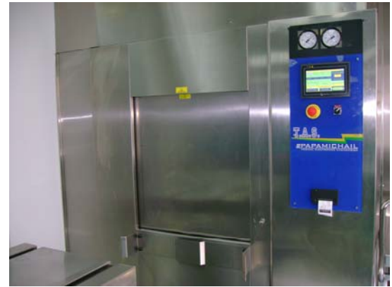
ΜΗΧΑΝΗΜΑ ΜΕΤΑ ΤΗΝ ΑΝΑΚΑΤΑΣΚΕΥΗ.....
