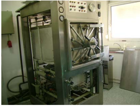
.....ΜΗΧΑΝΗΜΑ ΠΡΙΝ ΤΗΝ ΑΝΑΚΑΤΑΣΚΕΥΗ
